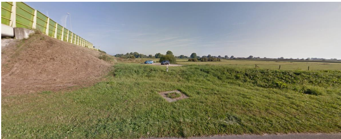
Afbeelding 5.10 Oostelijke aansluiting primaire waterkering op landhoofd Maasbrug bij Oud Empel (Google Maps)
