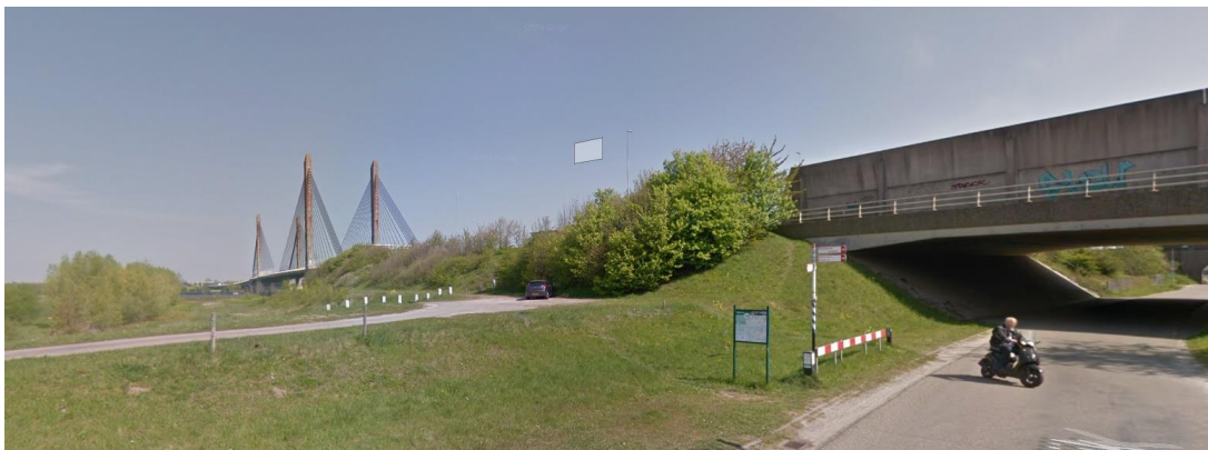
Afbeelding 5.6 Westelijke aansluiting primaire waterkering op landhoofd Waalbrug bij Zaltbommel (Google Maps)
