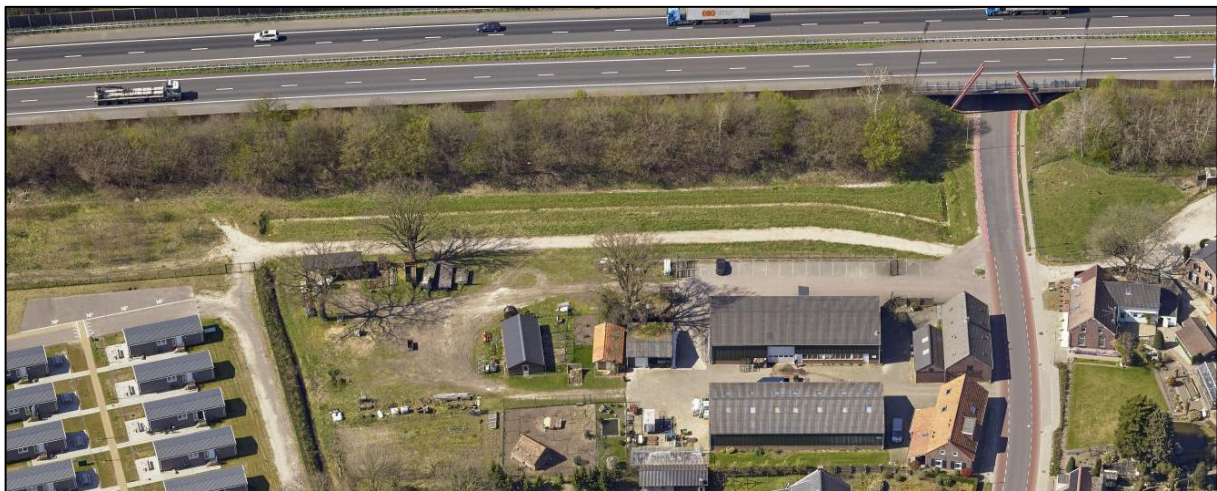
Afbeelding 7. Huidige situatie locatie beoogde verbindingsweg, noordelijke zijde c.q. aansluiting Stationsweg
