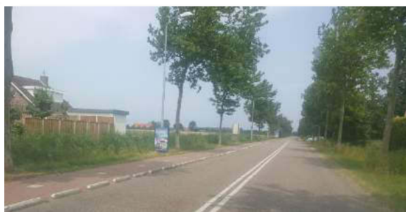
Foto 1: boven: rijbaan gemengd verkeer (links BIBEKO, rechts BUBEKO) en onder fietspad in twee rijrichtingen met beperkte ruimte tussen berm.
