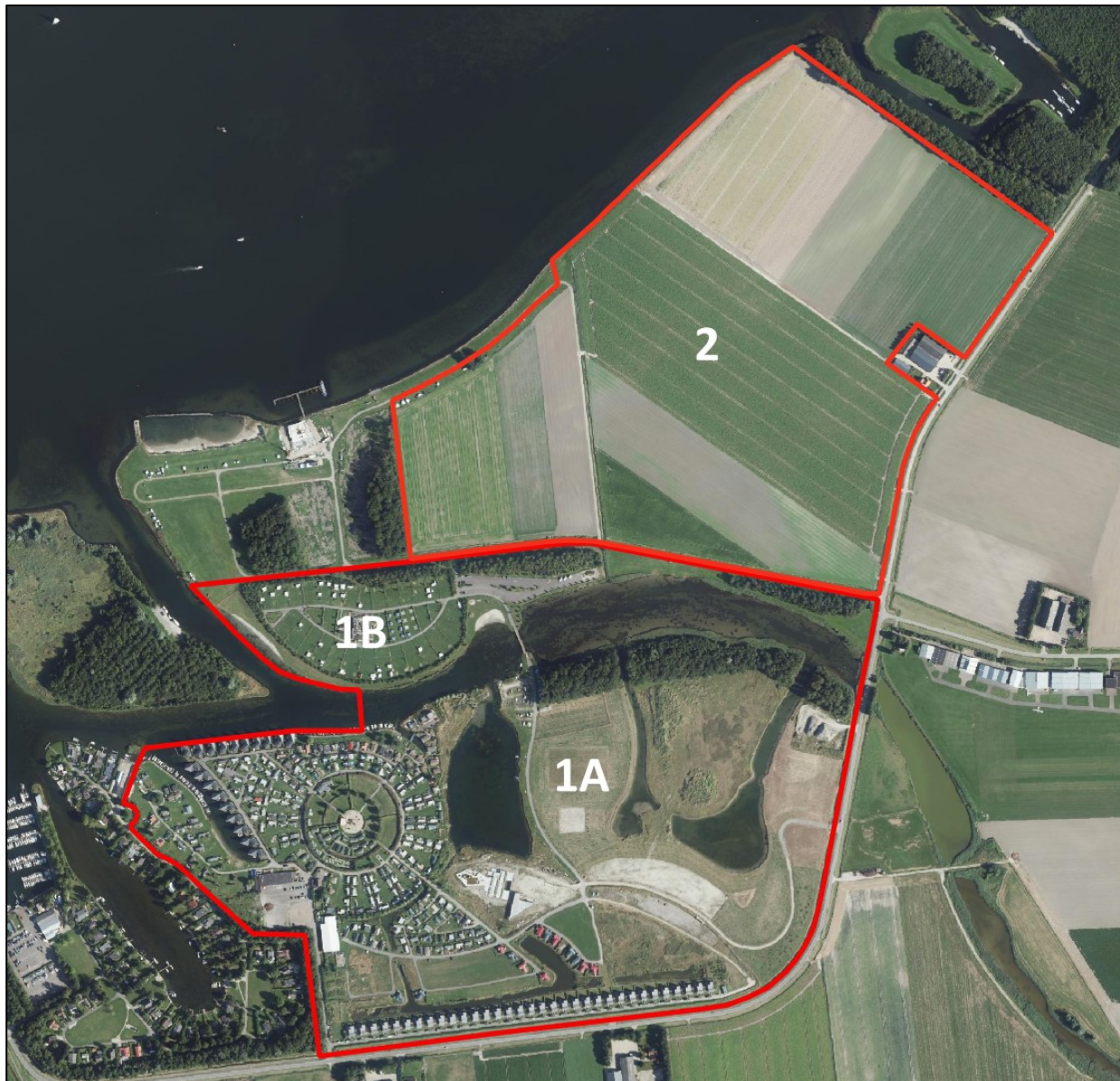
Afbeelding 2.1.2. Luchtfoto van het projectgebied (binnen het rode kader) met hierin het voormalige vakantiepark (1A), de voormalige Staatsbosbeheer camping (1B) en agrarische percelen (2).
