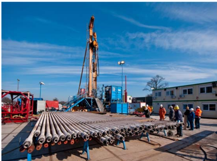
Figuur 3-4: Boormast bij proefboring ISH-01.
