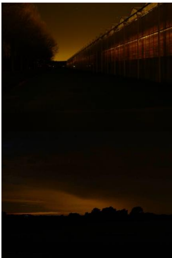
Lichtemissie uit een kas met bovenafscherming; bij de afgeschermdde kas wordt de emissie van licht zover teruggedrongen dat de lichtvervuiling aan de horizon niet meer bepaald wordt door de kas.
