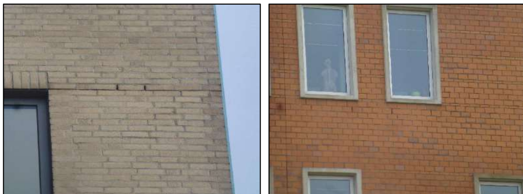
Figuur 4.3. Aanduiding stootvoegen in de gebouwen binnen het plangebied (linker foto betreft één van de twee kantoorgebouwen en de rechter foto betreft het LIFE College). Deze stootvoegen bieden vleermuizen toegang tot de spouwmuur waar zij beschermde verblijfplaatsen kunnen hebben.
