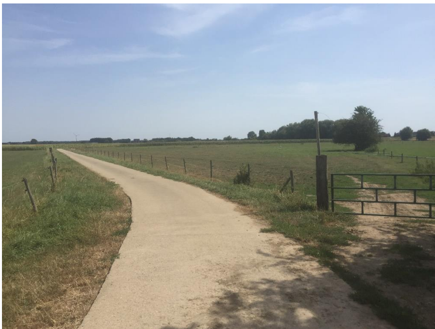
Foto 1: tracé Ammerzoden met betonpad
