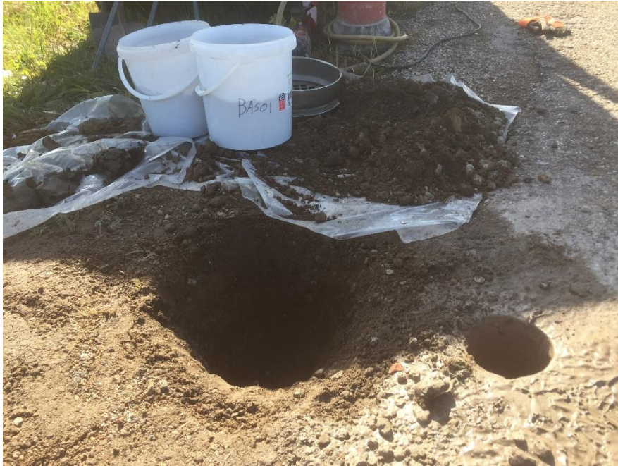
Foto 9: asbestgat BAS01 tracé Bokhoven
