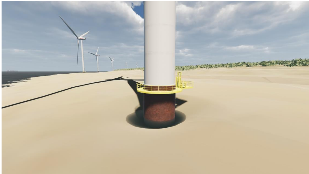
Figuur 13.12 Impressie vorming scour-hole
