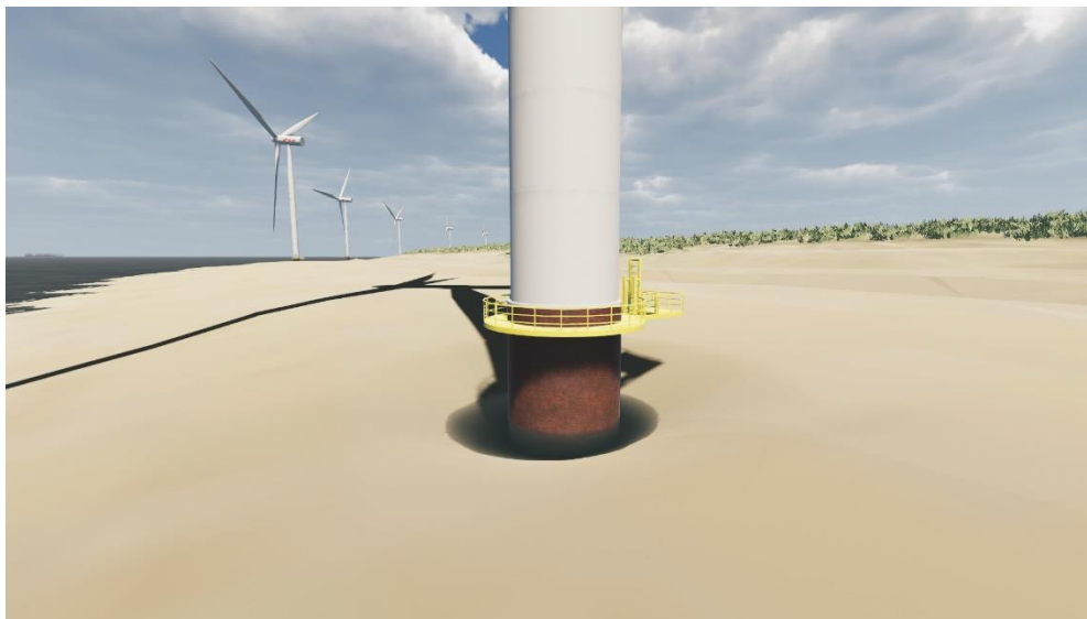
Figuur 16.14 Impressie vorming scour-hole
