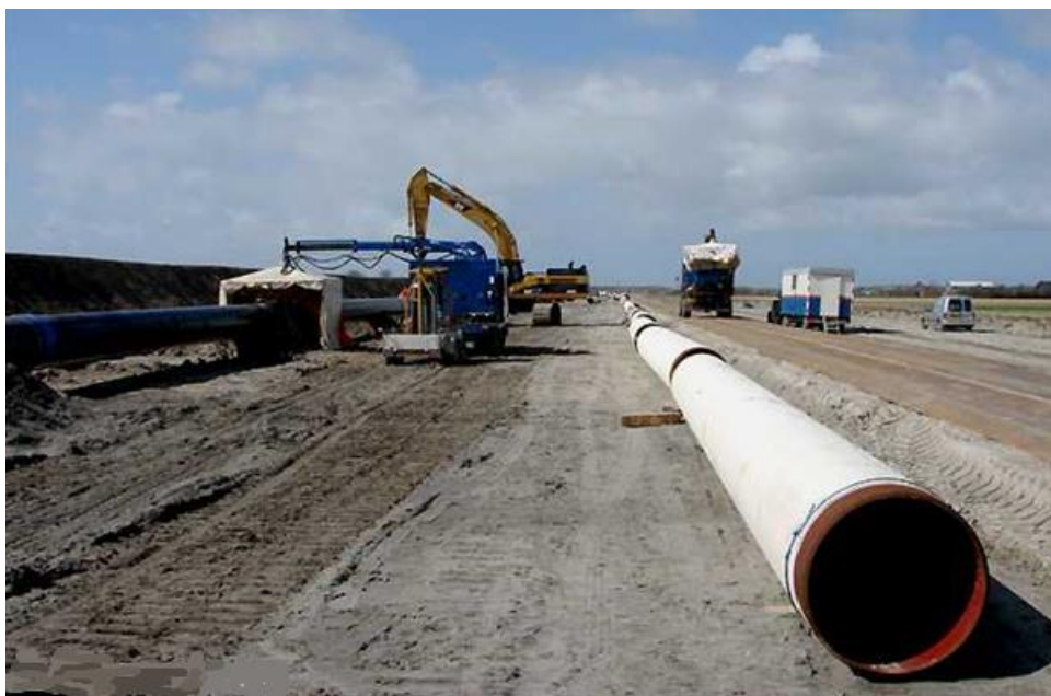
Figuur 3.23. Aanleg leiding in leidingstrook
