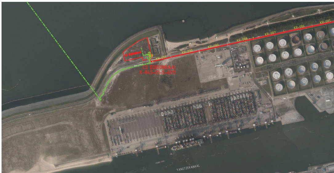
Figuur 3.17. Compressorstation Edisonbaai en kruising zeewering
