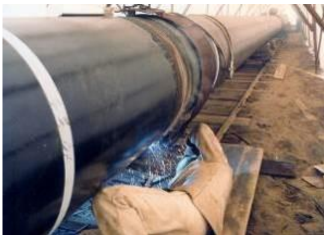
Figuur 3.24 Lassen van de leiding
