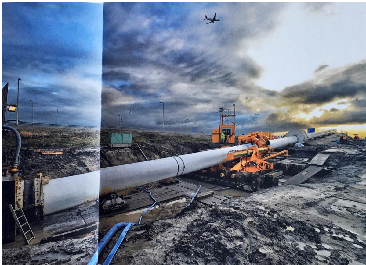
Figuur 3.34. Opstelling direct pipe boring
