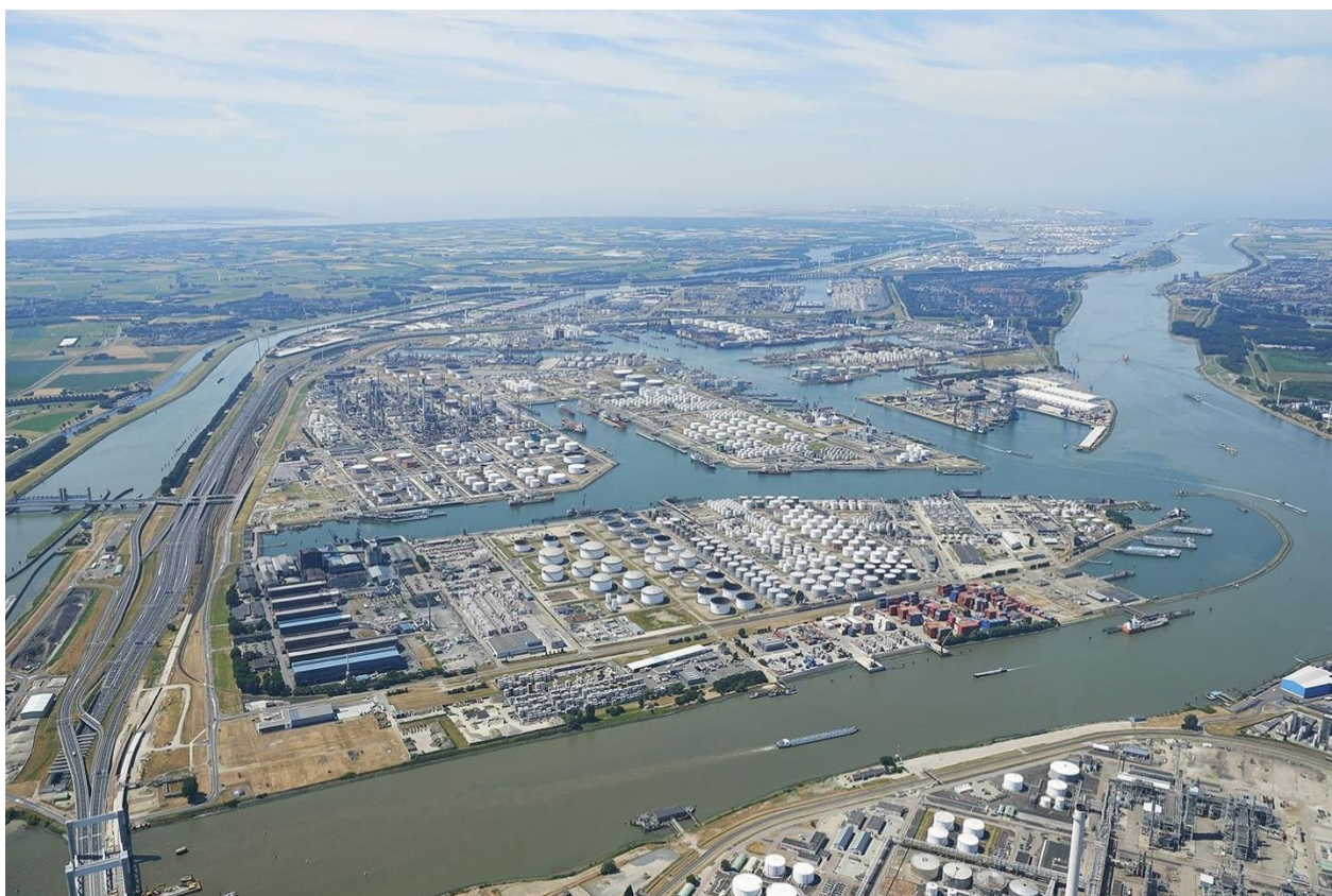
Figuur 3.2. Luchtfoto Botlekgebied (bron: Havenbedrijf Rotterdam, 2019)
