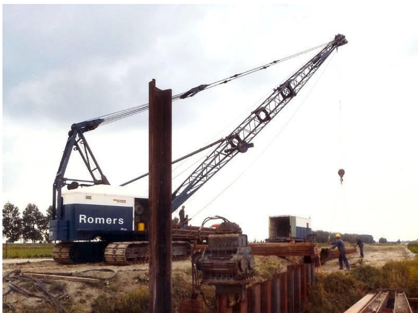
Figuur 3.28. Slaan van damwand
