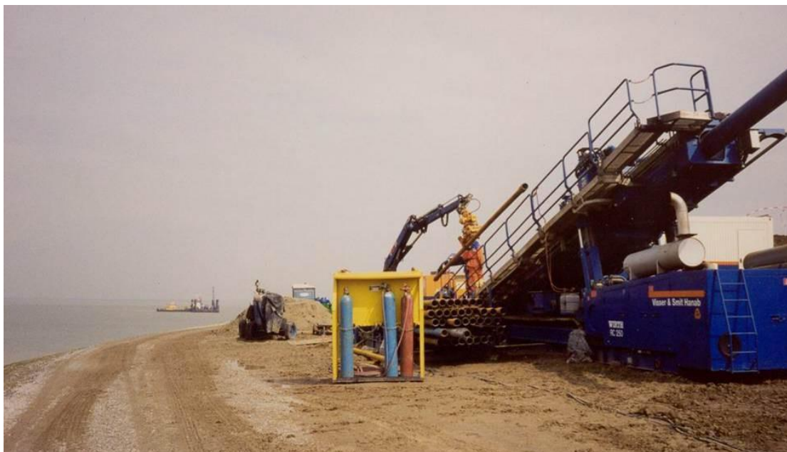
Figuur 3.31. Foto van een boorstelling voor HDD-boring
