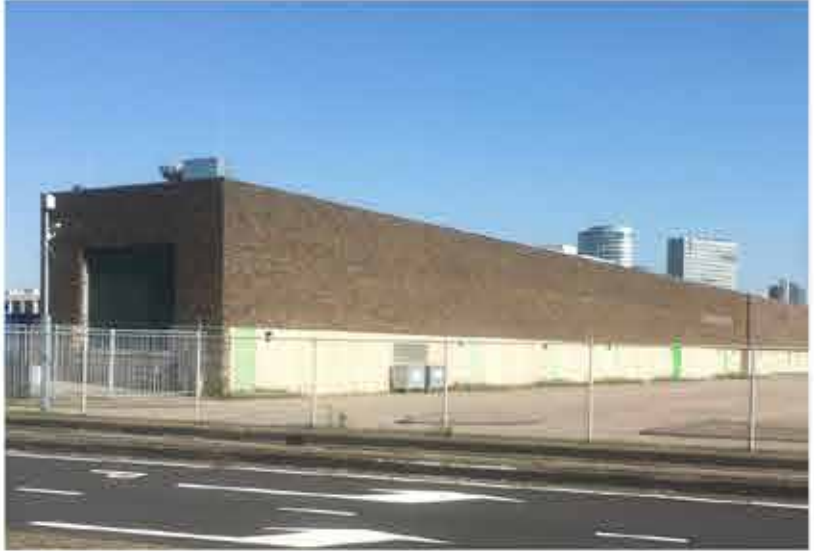
Zeer lang transformatorhuis
