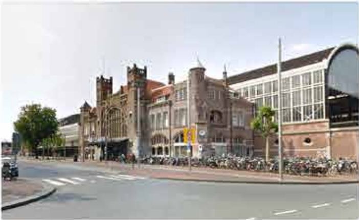
Station Haarlem met perron overkappingen en een stationshal
