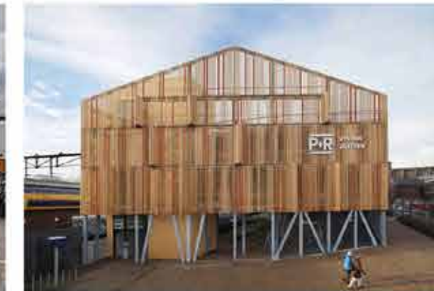
P+R parkeergarage, locatie eenvoudig herbruikbaar
