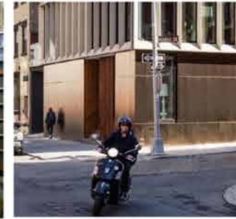
Toegangspunt parkeren opgenomen in gevel
