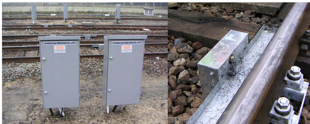
Figuur 5-2 Spoorstaafconditioneringssystemen
