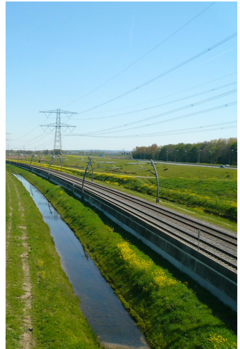
Zicht op de Betuweroute met de A15
