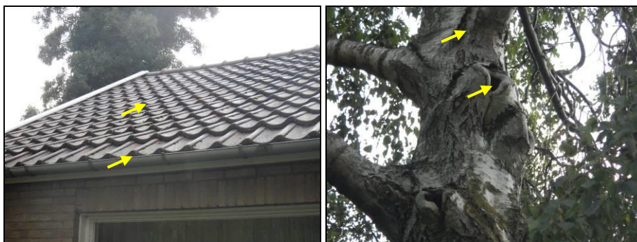
Figuur 11. Mogelijke verblijfplaats van vleermuizen in plangebied 3.
