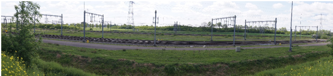
Figuur 12.10 Plangebied en het 'infrastructuurlandschap'. Op de achtergrond de A15 (bron: Tauw)
