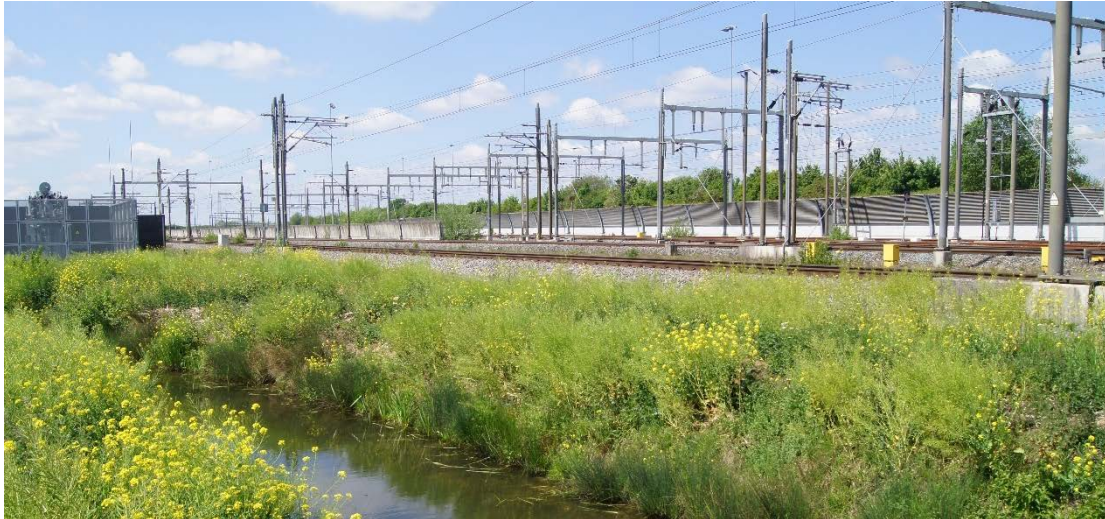
Figuur 12.17 Plaats waar de nieuwe ontsluitingsweg in alternatief 2 via een tunnel onder de bestaande Betuweroute gaat en het RTG bereikt, gefotografeerd vanaf de Hoge Brugstraat richting noorden. Bron: Tauw
