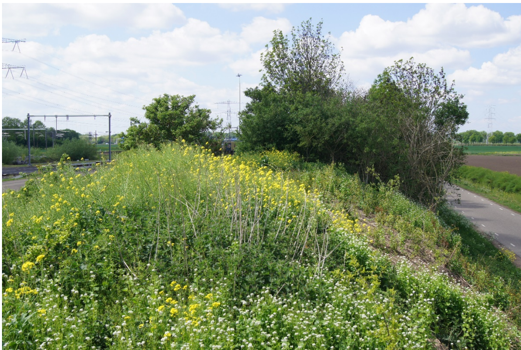
Figuur 16.3 Detail van de bestaande geluidswal, tussen de Reethsestraat en de bestaande spoor-infra (foto genomen in westelijke richting)
