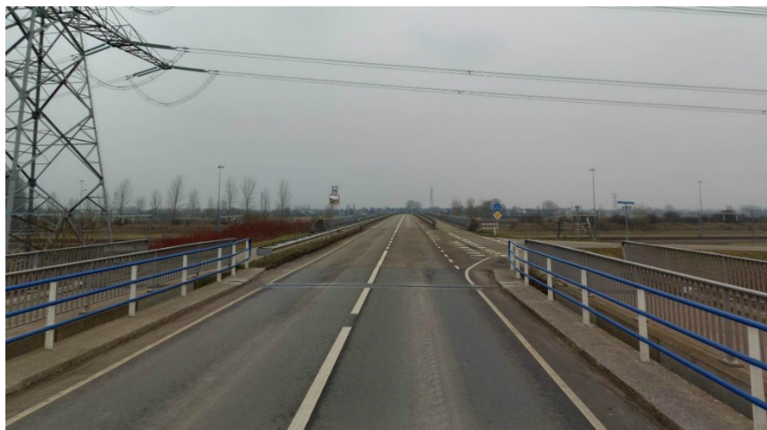
Figuur 8.5 Tielsestraat ter hoogte van De Hoge Brugstraat (bron: Cyclomedia)
