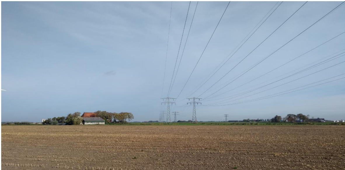
Afbeelding 2.4 Open landschap met bestaande hoogspanningsverbinding in zoekgebied Bolsward (bron: eigen foto)
