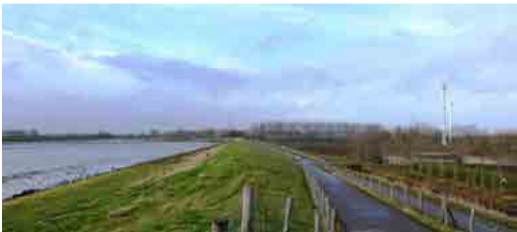
Figuur 10.6 Zeedijk van de Willem-Annapolder, ter hoogte van de RWZI, met de Biezelingsche Ham
