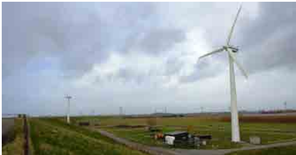
Figuur 4.23 Zicht vanaf de Zeedijk op de bestaande turbines bij Schore
