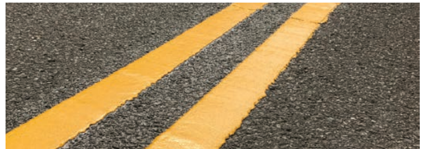
Grijs/zwart asfalt verrijkt door felgekleurde thermoplast lijnen met scherpe randafwerking
