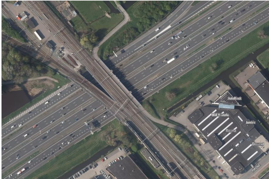
Figuur 3 Bestaande viaducten Leidschendam
