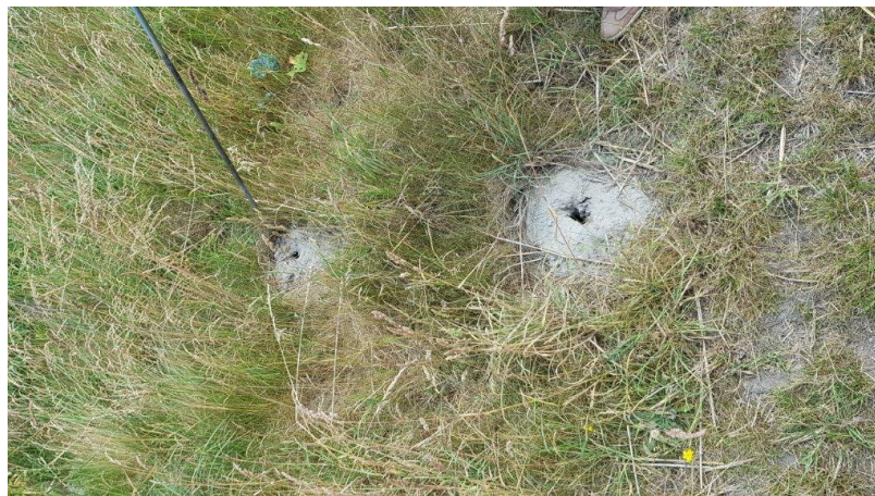
Figuur 61 Onderzoek naar de bekleding op het binnentalud
