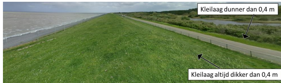
Figuur 62 Duiding dikte van kleilaag op het binnentalud
