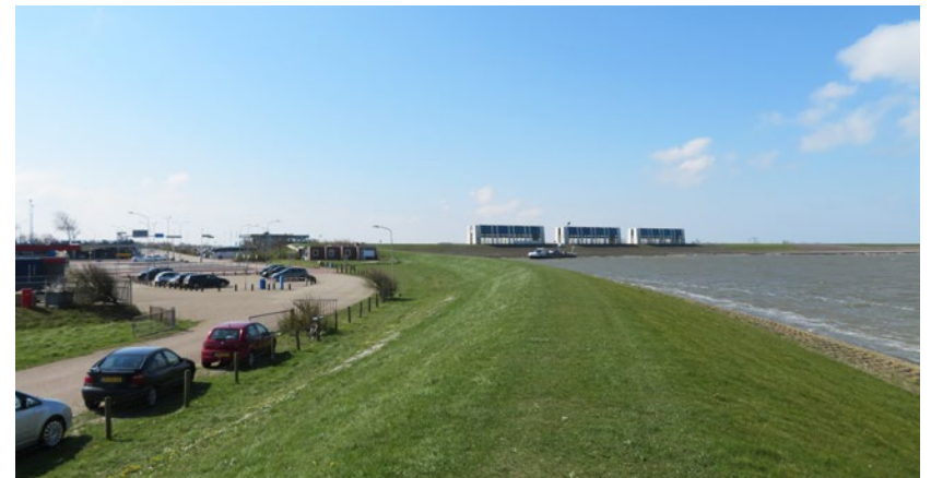
De westelijke havenarm met gras op het buiten- en binnentalud
