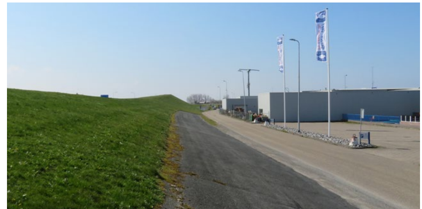
Helder dijkprofiel in het oostelijk deel van de haven, dat wordt onderbroken door het kunstwerk op de dijk
