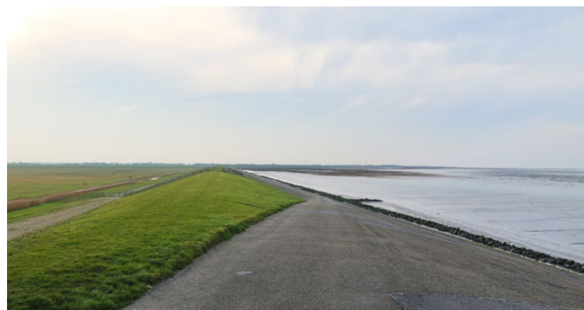
Lauwersmeerdijk aan Friese zijde bij de Hoek van de Bant
