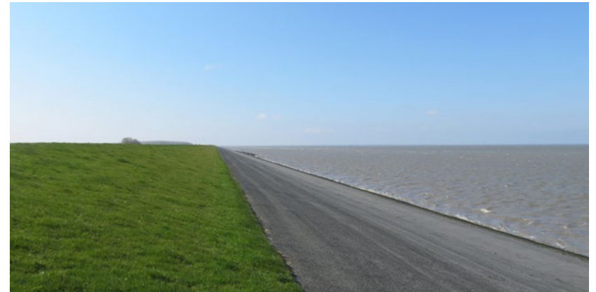
Buitentalud van het landelijk dijktracé met gras op de kop van de dijk, en asfalt daaronder
