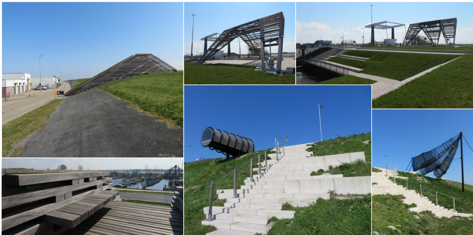
Doordat de verharding rond de kunstwerken in het kader van Lauwersom op het talud van de dijk geplaatst is wordt de lijnvoering van de dijk minder helder verrommeld het totale beeld
