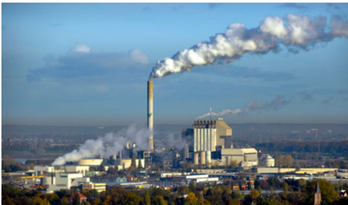
Figuur 8: Schoorsteen; de emissies vinden plaats aan de bovenkant met een verticale snelheid, waardoor er een pluim wordt gevormd
