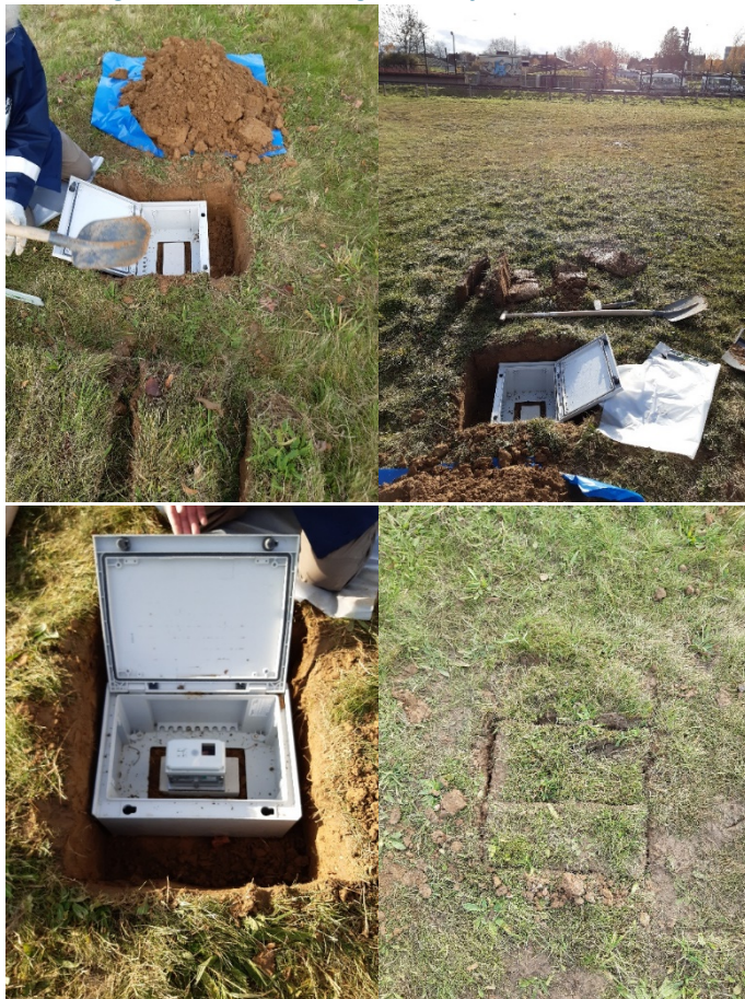
Afbeelding 1.5 t/m 1.8: Aanbrengen meetsysteem onder maaiveld
