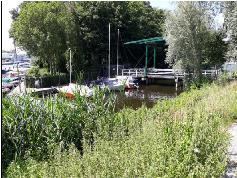
35 Wandel/fiets ophaalbrug aan de Jachthavenweg.
