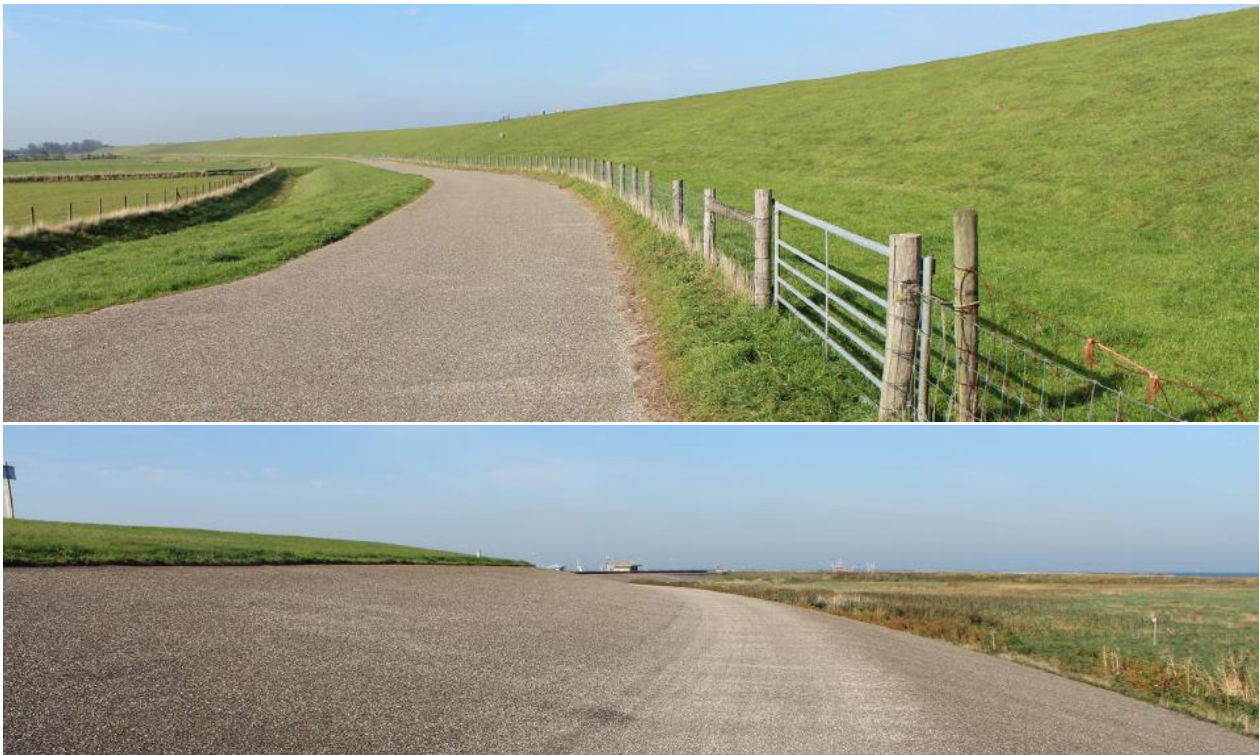
Figuur 4: Wieringer Zeewering aan de binnenzijde (boven) en de Waddenzee-zijde (onder)
