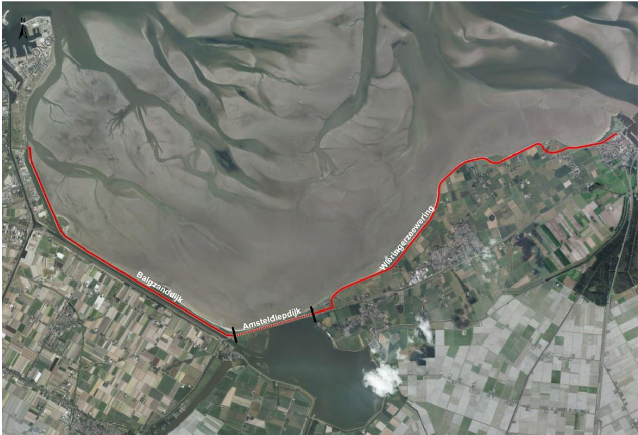
Figuur 2: Projectgebied: Balgzanddijk, Amsteldiepdijk en Wieringer Zeewering
