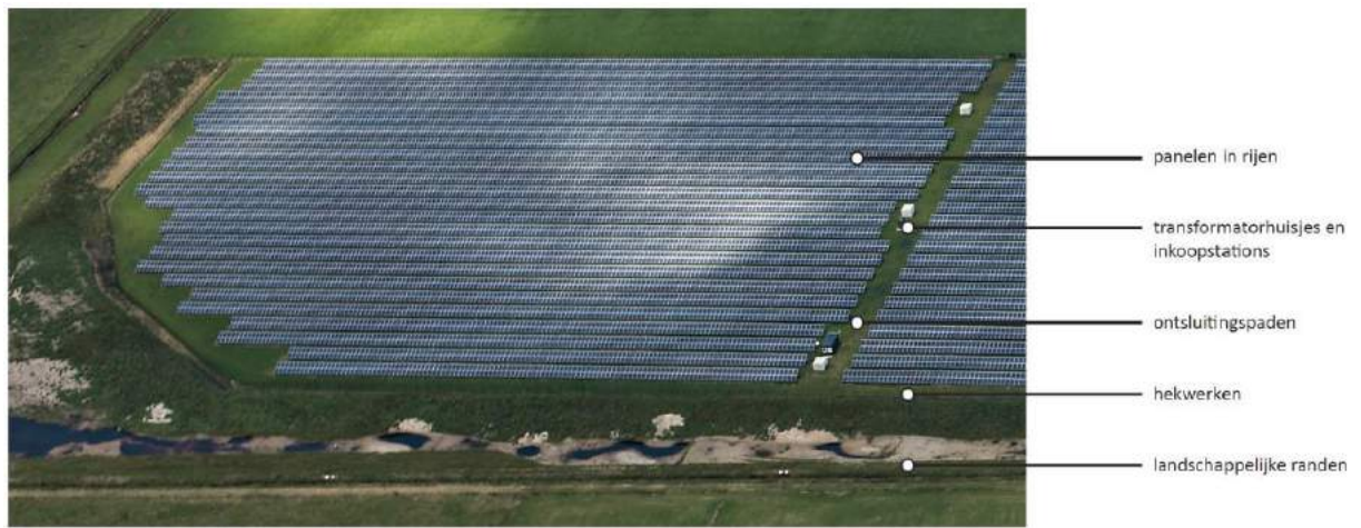
Figuur 40 Elementen van een zonnepark.
