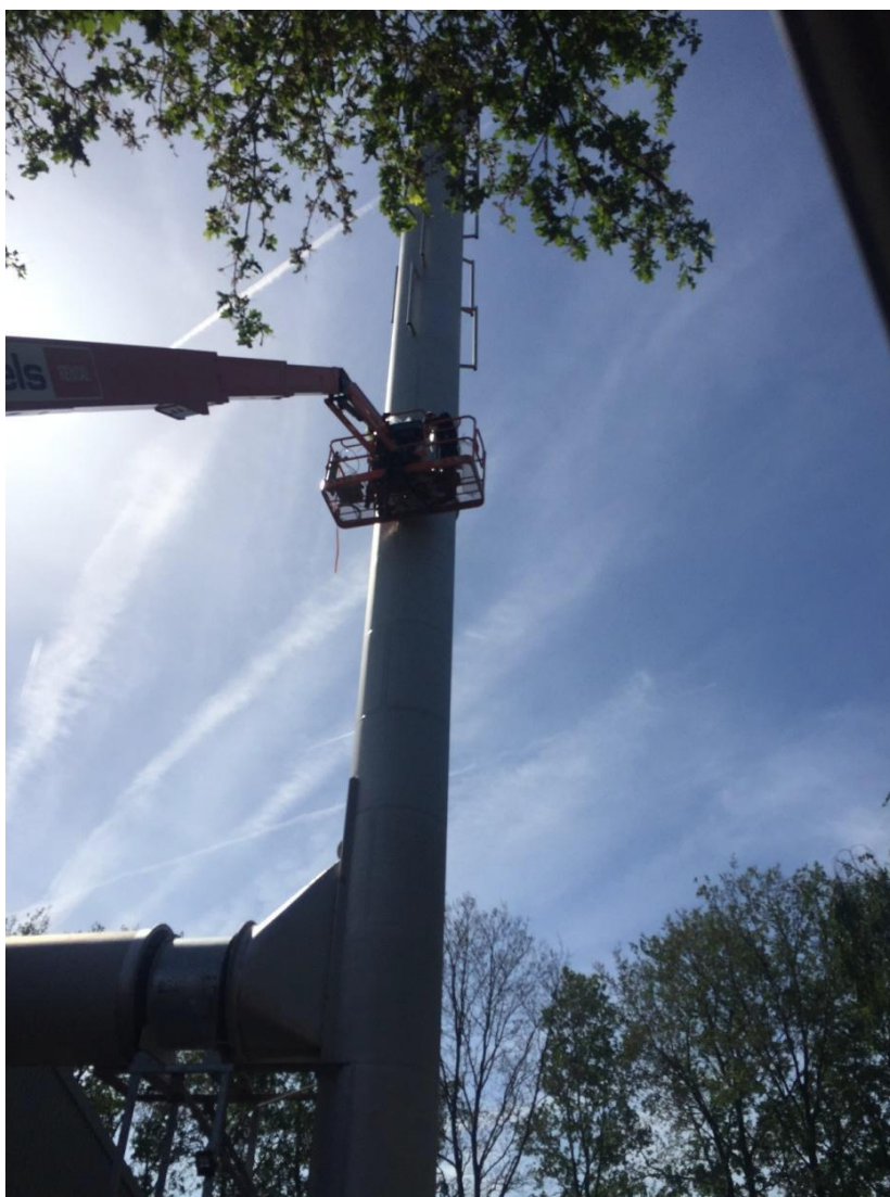
Met behulp van een hoogwerker zijn de meetpunten benaderd
