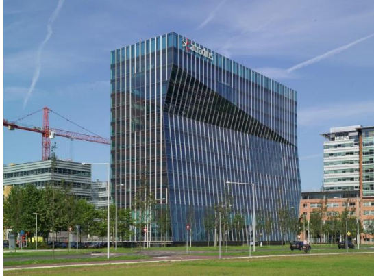
Figuur 2.13 – Kantoren Rieker Business Park
