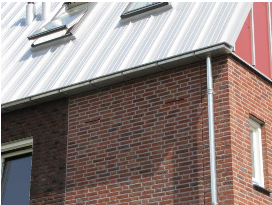
Figuur 37. In de gevel verwerkte vleermuisvoorzieningen op een nieuwbouwlocatie in Angeren ('Nije Hof'). Bron: http://www.xjochemx.nl/gierzwaluwen/gierzwaluwen_angeren .
