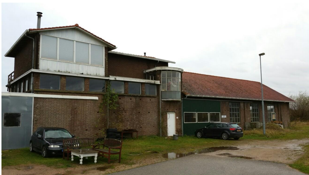
Figuur 10. Het voormalige transformatorhuis in Meinerswijk lijkt geschikt voor vleermuizen door vele kleine kieren en openingen.
