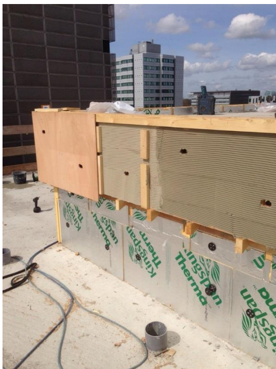
Figuur 35. Een vleermuisvoorziening in aanbouw rondom een liftschacht (Incubator, Universiteit Utrecht). De voorziening is vooraf in het ontwerp opgenomen en maakt onderdeel uit van de constructie.
