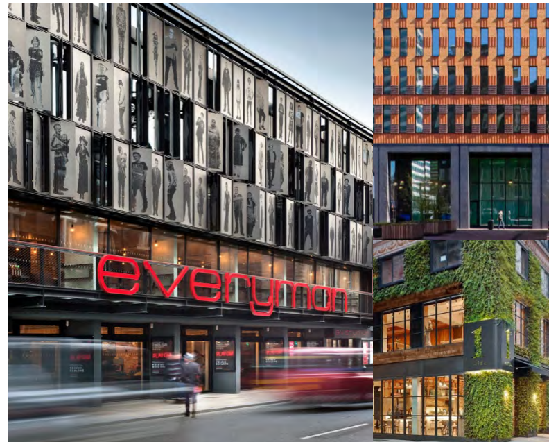
Snelwegzijde ondanks noodzaak voor meer geslotenheid toch aantrekkelijk. Plint en bovenbouw in samenhang ondanks verschillen.
