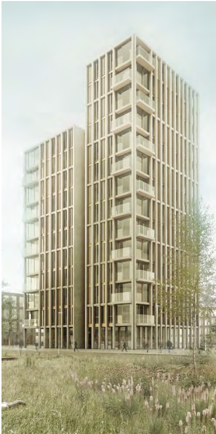
Singeltoren, Leiden (in aanbouw) 45 meter hoog
