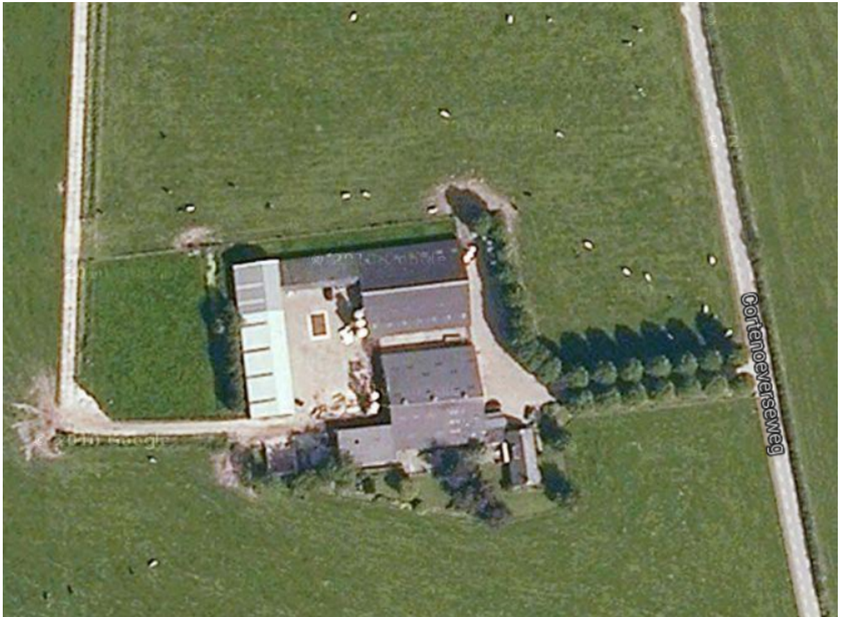
Figuur 2.1: voormalige situatie veehouderijbedrijf (bron: Google maps)
