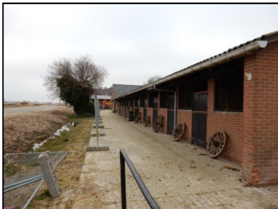
Figuur 6. Westelijk deel manegeschuur.
