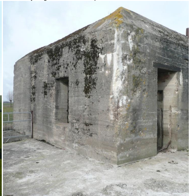
Foto 2.4 Eén van de bunkers bij Nansum
