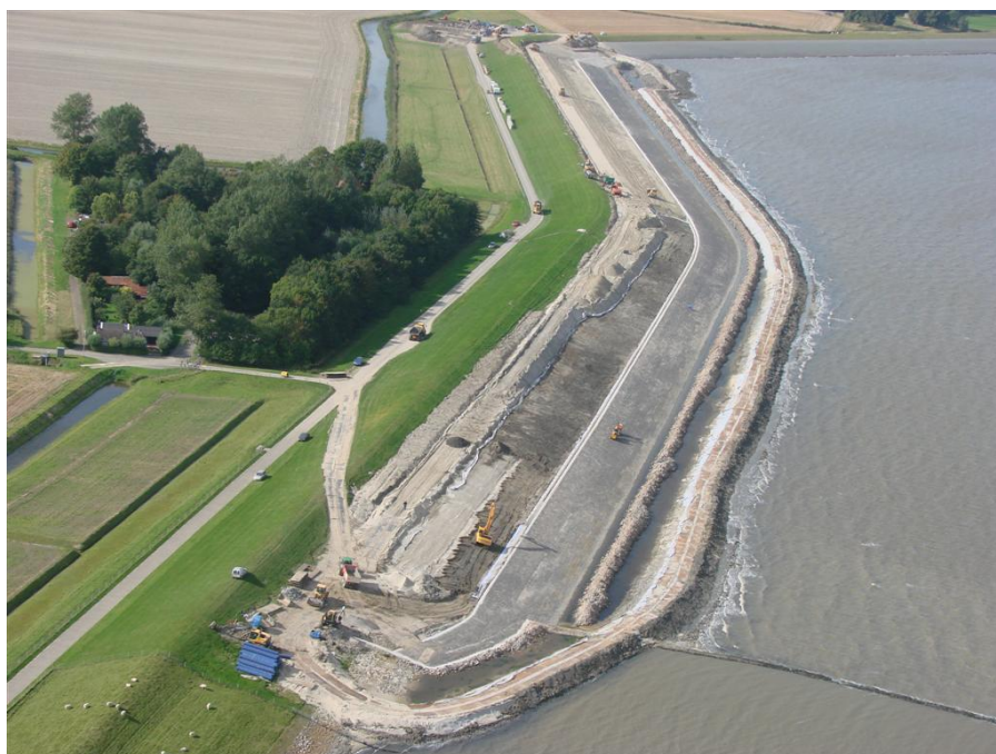
Foto 1 Voorbeeld buitendijkse werkstrook (dijkverbetering Nieuwstad, 2009)
