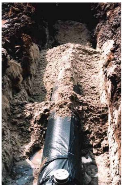
Figuur 6.5 Aanleg IT-riolering
