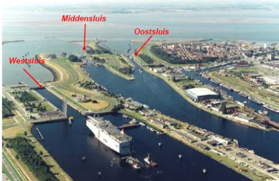
Figuur 2: Overzicht Sluisencomplex Terneuzen
