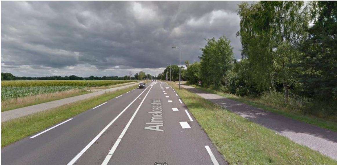
Afbeelding 6.3 Profiel N743 nabij het plangebied met zicht op de aansluiting met VRI (www.google.com)
