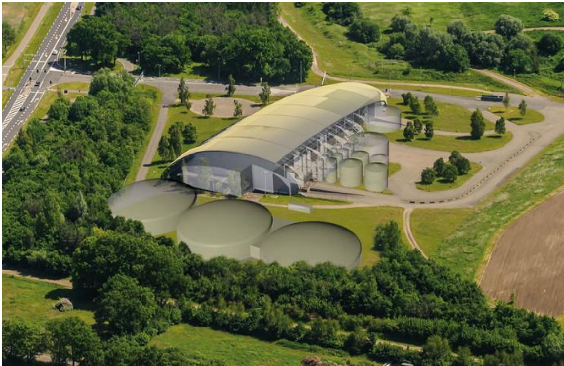
Afbeelding 2.1 Impressie silo's en mestverwerkingsinstallatie
