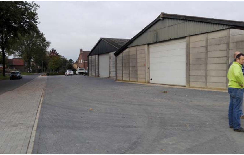
Loonbedrijf Coenen breidt uit op één van de nieuwe bedrijfskavels. De loods op de voorgrond wordt gesloopt.
