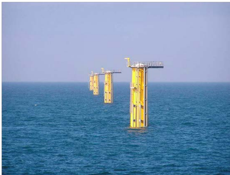
Figuur 6-5 Foto van een funderingspaal van een turbine in het Prinses Amalia park (foto van website: http://www.prinsesamaliawindpark.eu/ )
