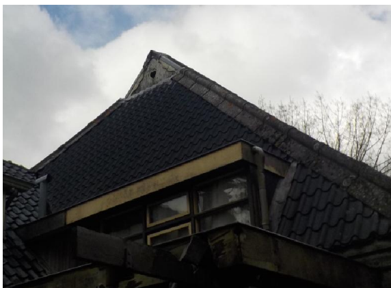
Figuur 4 Toegang voor kerkuil en steenuil in schuur Ter Laan 10 via uilenbord
