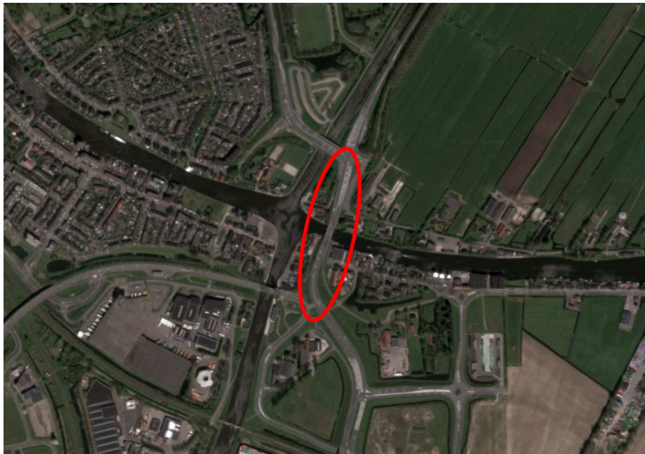
Figuur 1.1: Luchtfoto Steekterbrug
