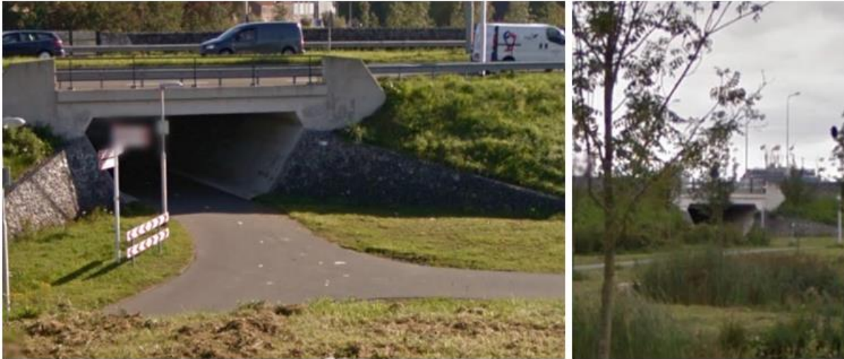
Figuur 7-3: huidige onderdoorgang Goudse Schouw (links zijde Goudse Schouw en rechts zijde Gouwestraat).
