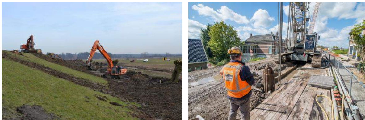
Figuur 54 Verschil in uitvoering grondoplossing en constructief
