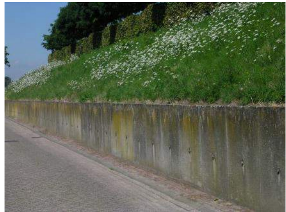
Figuur 51 Voorbeeld damwand in talud dijk
