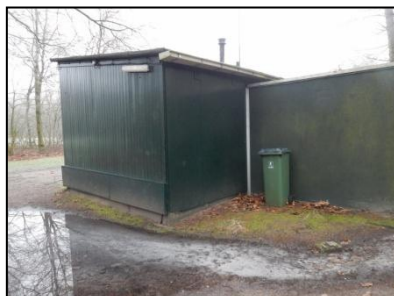
Figuur 7. Houten bebouwing Onderlangs.
