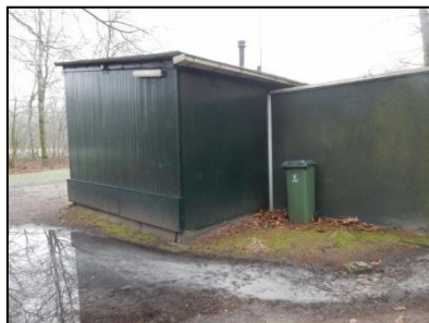
Figuur 7. Houten bebouwing Onderlangs.
