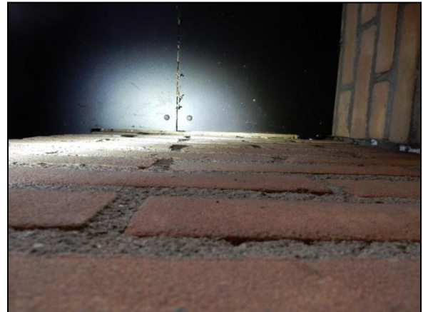
Figuur 13. Ruimte achter betimmering van het kantinegebouw.
