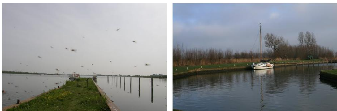
Foto 1 Aanlegplaatsen in oostelijk Ketelmeer.
