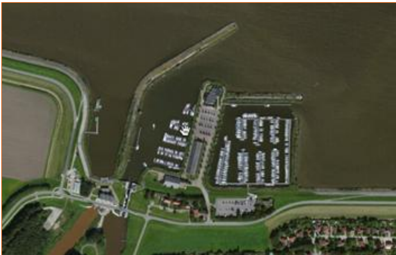
Figuur 1-1 Huidige situatie Ketelhaven-buitendijks.
