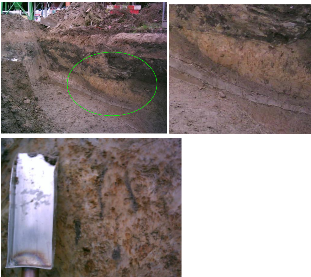
Figuur 7.3 Foto's kleilaag, ontgraving bouwplaats Masiusplein, Zevenaar.
