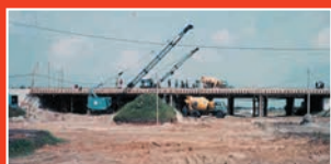
Begin jaren '70 Aanleg A67
