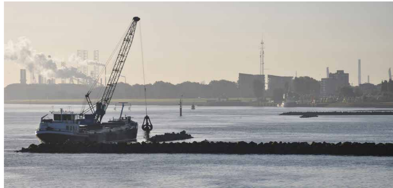
Groene Poort Zuid in aanleg (oktober 2016). De stenen zijn afkomstig van de glooing bij Koole Terminals in Botlek (foto: Wiebe Pannekoek)
