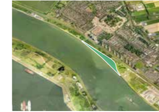
○ Groene Poort Noord, Maassluis
