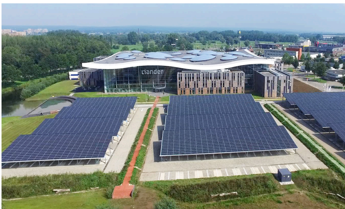
7. Liander, Zonnepanelen op parkeerdek en fietsenstalling ( www.deingenieur.nl )
