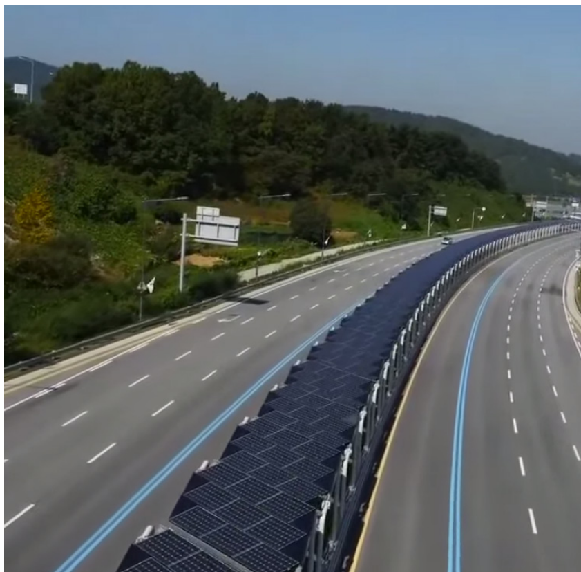
28. Fietspad overdekt met zonnepanelen, Seul ( wonderfulengineering.com )
