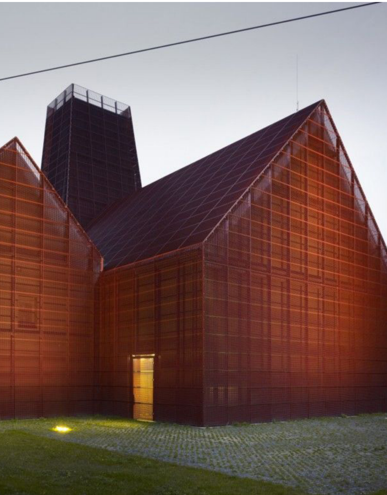
12. Aardwarmtecentrale, Den Haag ( www.architectuur.nl )
